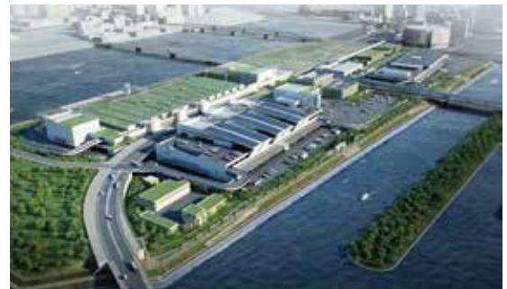
豊洲市場全体イメージパース図 提供：東京都中央卸売市場
